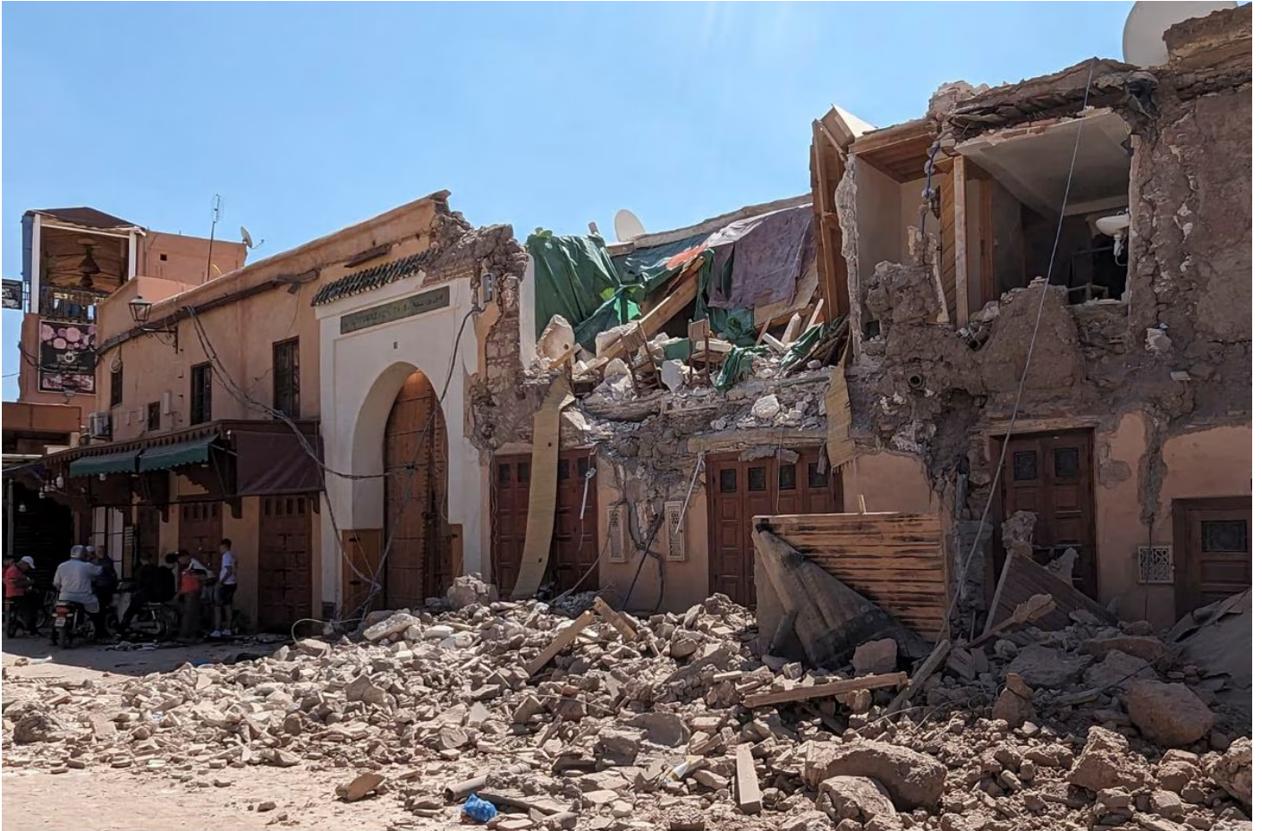
Edificios derruidos por el terremoto. JAVIER PICAZO (EFE)
