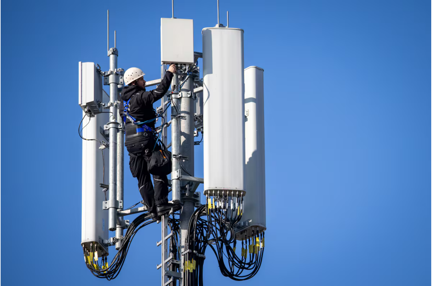
Un técnico realiza trabajos de reparación en una antena 5G de la red móvil en Baviera. DANIEL KARMANN (PICTURE ALLIANCE / GETTY IMAGES)
