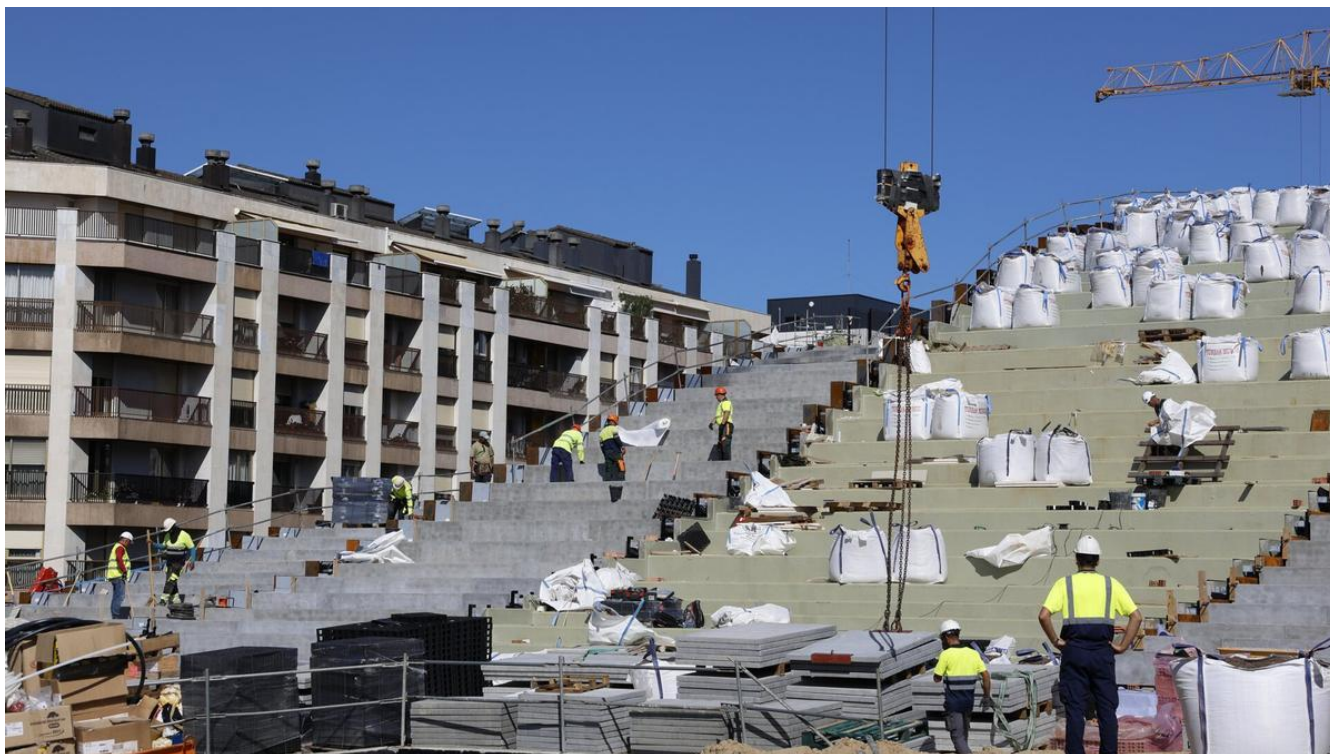
Obras en la cubierta del edificio GOe / JUAN HERRERO / EFE
