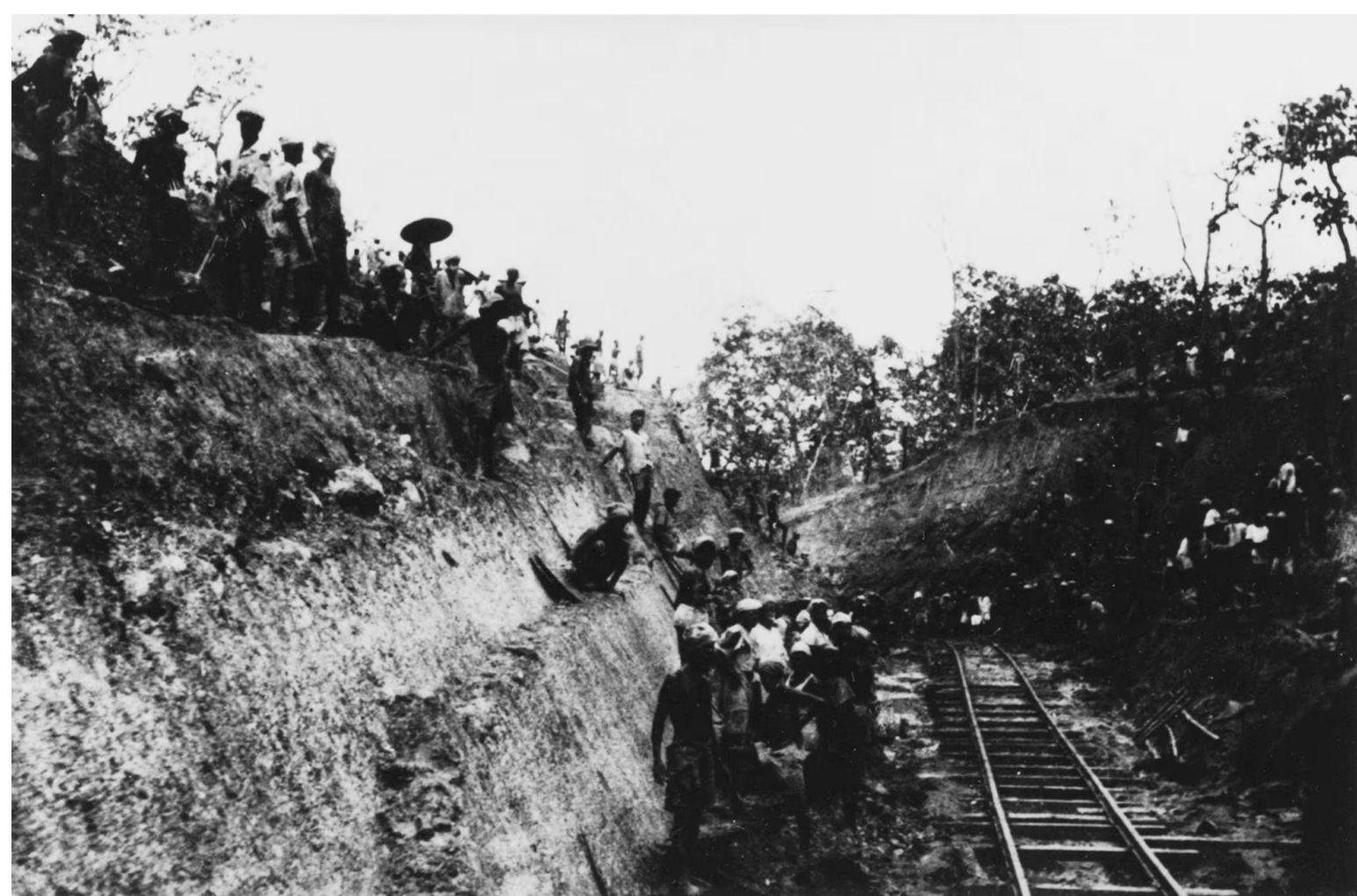
Construcción de la línea del Ferrocarril Tailandia-Birmania, en la que los japoneses obligaron a trabajar a 180.000 civiles asiáticos y 60.000 prisioneros de guerra aliados.
