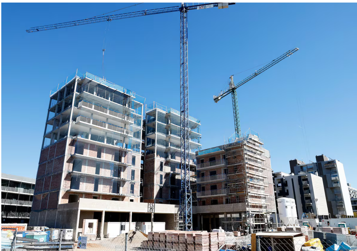
Viviendas en construcción en Barcelona. ANDREU DALMAU (EFE)
