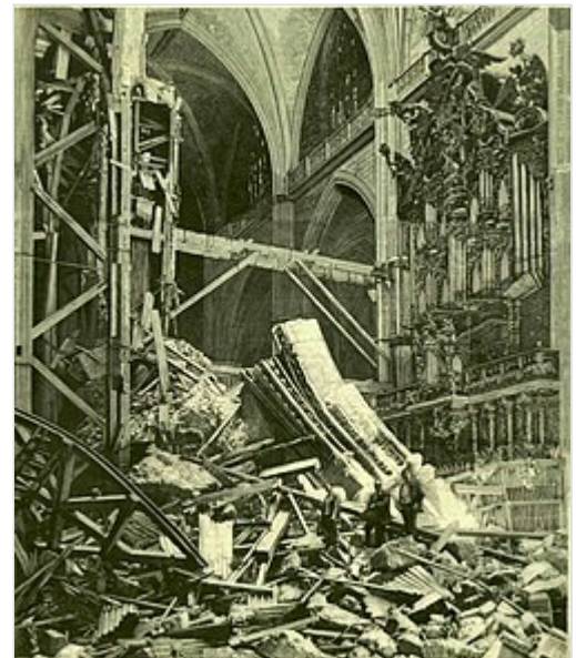
En 1888 se produjo un derrumbe de una de las bóvedas provocado por la rotura de un pilar
