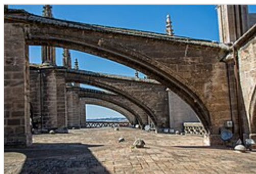
Cubierta plana y arbotantes
