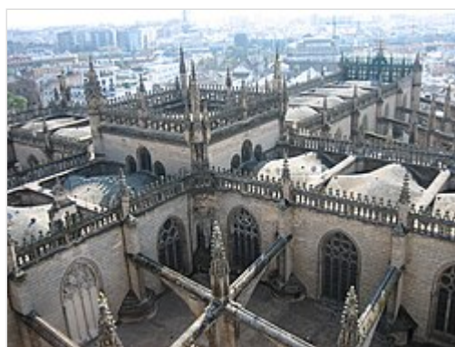
Trasdosado cerámico en las cubiertas de la nave principal, cimborrio y crucero
