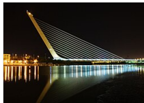
Puente del Alamillo, de Santiago Calatrava, por donde discurre la SE-30 sobre el Guadalquivir
