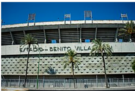
Exterior del estadio del Real Betis
