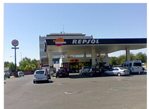
Estación de servicio en Sevilla
