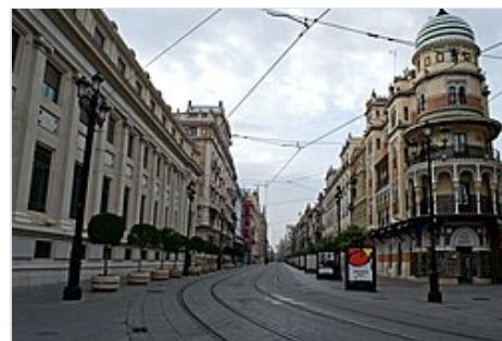
Avenida de la Constitución tras las obras de peatonalización, por la que circula el tranvía
